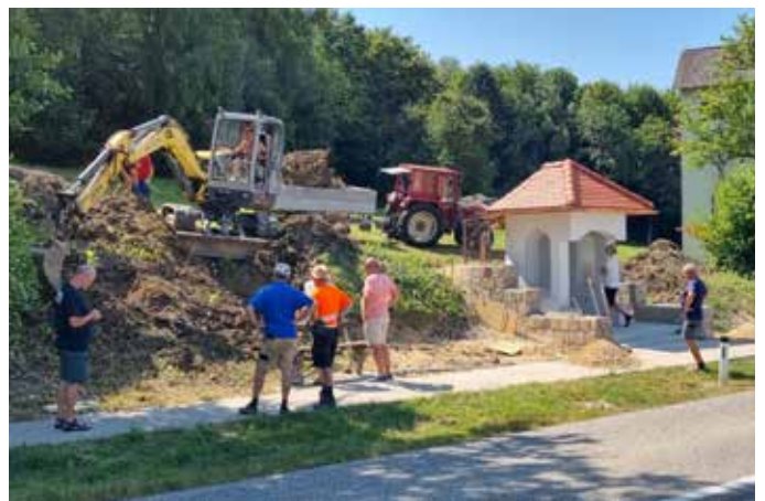
Erdarbeiten am 22. Juli 2022
