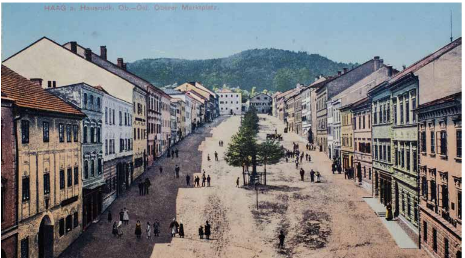
Aufnahme aus 1916, Oberer Marktplatz, Haag am Hausruck
