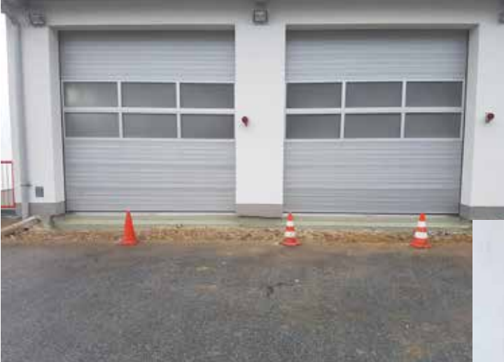
Sanierung der Tore von TLFA und RLFA
